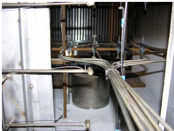
Abb. 42: Messebene in der Türöffnung
